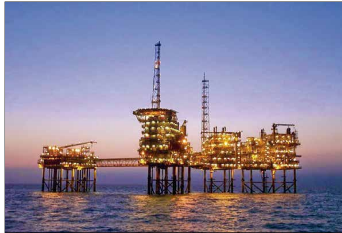
A corrosão induzida por cloro é causa comum de falha nas aplicações offshore
